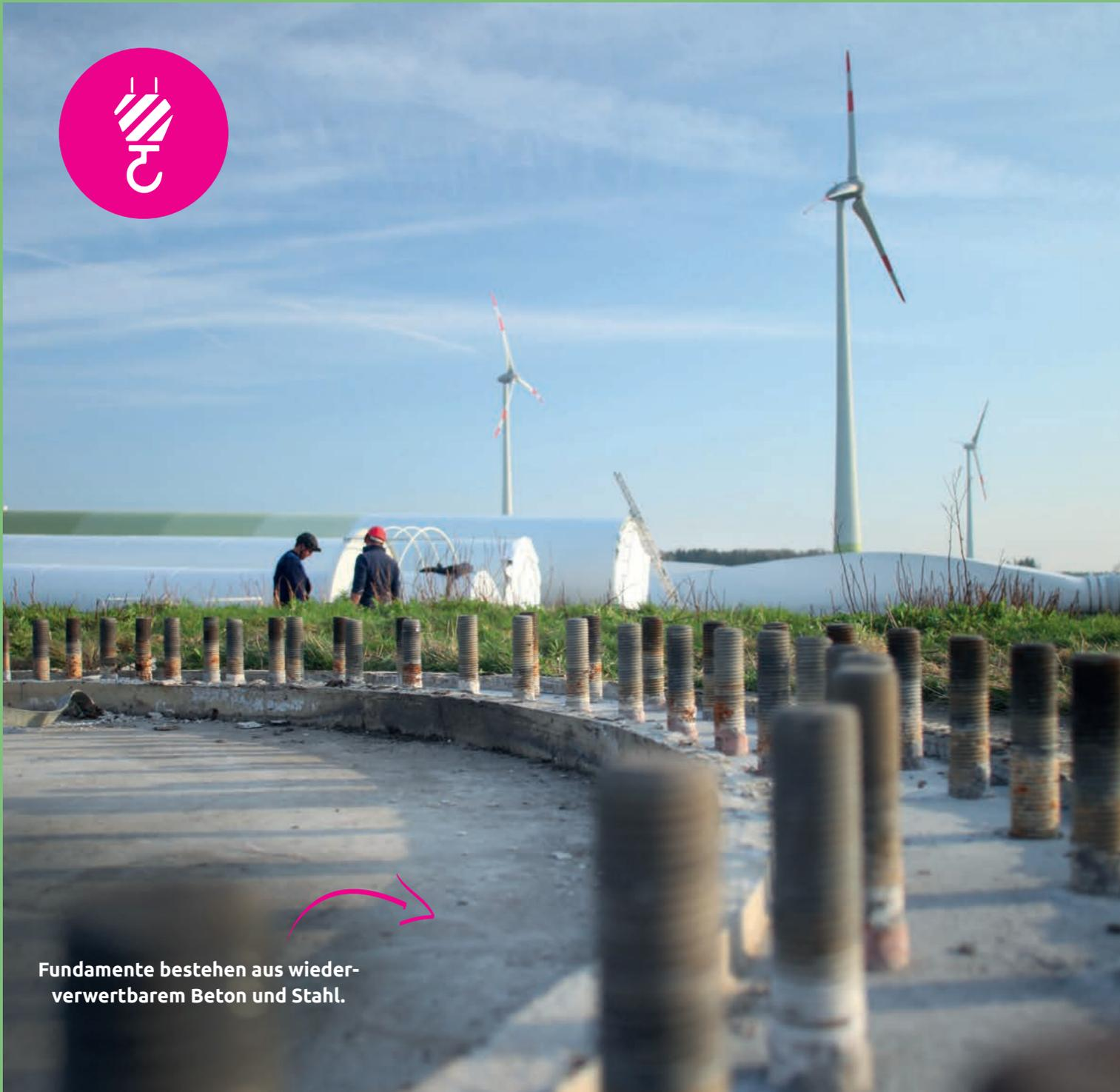
Fundamente bestehen aus wiederverwertbarem Beton und Stahl.
